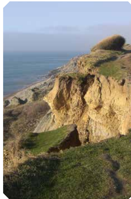
Falaise effondrée en 2008 à Audresselles
