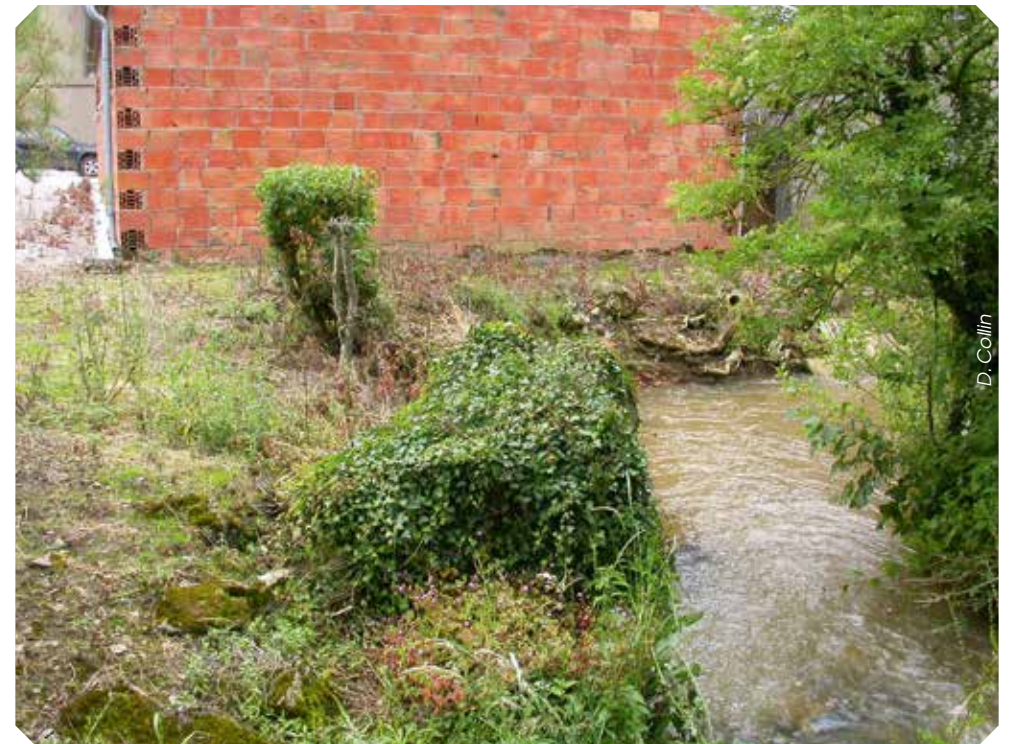
Une maison neuve en zone humide
