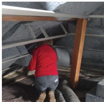
L'isolant est placé entre les montants et il est comprimé légèrement dans le sens de la longueur pour bénéficier de son effet ressort. L'isolant reprend immédiatement sa forme initiale en épousant parfaitement les montants, évitant ainsi les risques de pont thermique. Un ajustement des lés d'isolant peut être nécessaire pour les rendre parfaitement jointifs.
