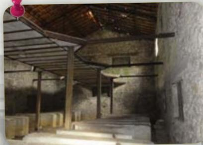
La grande halle : le plancher, dont la forme correspond à l'emplacement des anciennes cuves de la distillerie, se compose d'une structure poteaux-poutres métalliques, avec une passerelle en béton. Il divise la hauteur du volume de la grande halle en deux parties quasiment égales et offre une configuration très identitaire.
