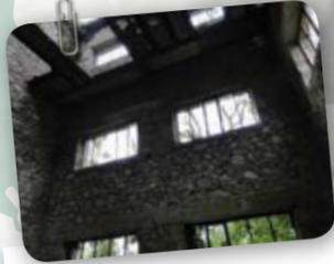
La tour offre de nombreux percements et des planchers bétons parfois très ajourés, implantés à des niveaux différents, qui répondaient à des usages de production très spécifiques.
