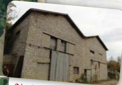
Les halles : les deux pignons en pierres au sud de la distillerie sont identiques, avec une toiture à deux versants et quelques percements composés. Leur volume très imposant peut être découpé en deux étages, tandis que la tour permet l'aménagement de 5 étages.
