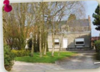
▫ Le logis, implanté au nord de la cour, bénéficie d'une façade avant plein sud. Malgré les apparences, ce volume reste le plus important de l'ensemble bâti. Il a subi des modifications dans les années 50. Ce volume en briques a été cimenté ; un brisis a été créé dans la toiture.
