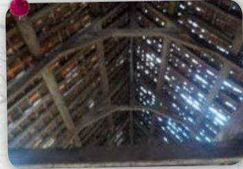
Quelques pièces de charpente sont cassées ou pourries. Cela reporte les charges horizontales sur les murs. Quelques tuiles manquent en toiture, ce qui participe à la dégradation générale de l'ouvrage.
