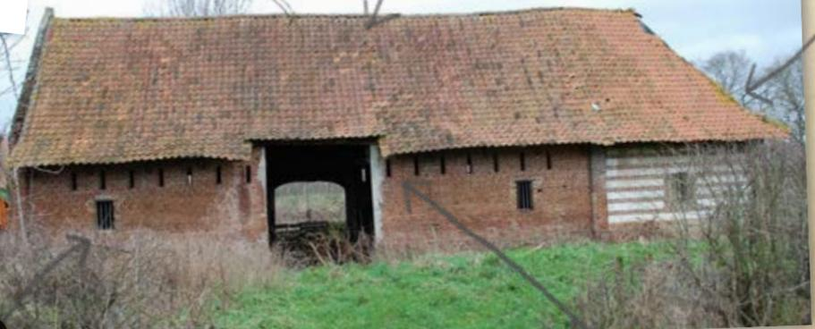
La grange se compose d'un bâtiment principal rectangulaire et d'un bâtiment secondaire qui assurait la liaison avec la partie démolie (bâtiment en retour présent sur les cadastres). Rythmée par des pignons en brique de 45 cm, elle comporte une partie en brique sur ossature bois et une partie en rouge-barre (alternance de lits de briques et de pierres blanches), assez rare. Ces pignons forment les éléments structurants du bâtiment. La toiture est revêtue de pannes flamandes, en bon état.
