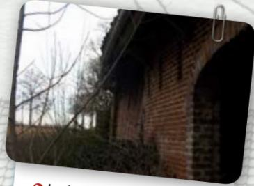
Le bâtiment ne présente pas de fondations : cela fragilise fortement la construction et explique les déformations des murs de façade. L'absence de dalle basse et de chaînage haut ne liaisonnent pas les quatre murs entre eux.
