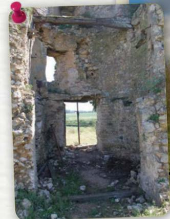
Le moulin possédait une porte au Sud et 5 fenêtres. Chaque ouverture bénéficie d'un appareillage spécifique, constitué de pierres taillées à dimension pour former l'encadrement de la baie.
