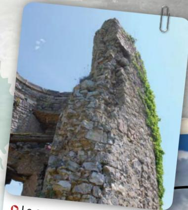
Le couronnement en pierre qui permettait la rotation de la partie supérieure du moulin assure également le chaînage haut de l'édifice.
