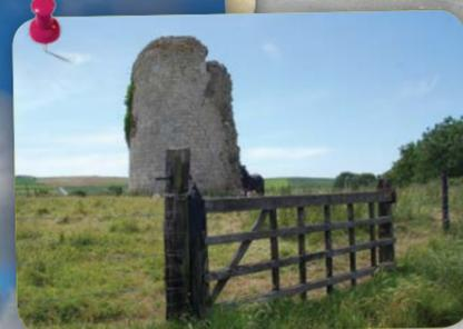
Une large éventration découpe le flanc Nord. De plus près, l'état de dégradation reste contrebalancé par la massivité des murs et la qualité des appareillages de pierre locale. Les dégradations résultent principalement de l'absence de toiture qui expose les maçonneries aux intempéries, de la présence de lierre qui envahit le flanc sud-ouest, de l'état des joints et de la partie du mur effondrée.
