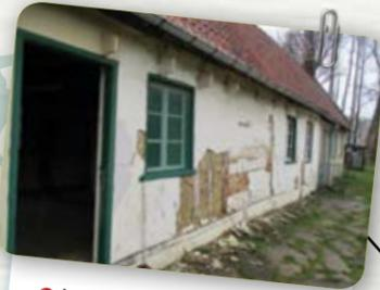
La partie centrale de la maison présente toujours son ossature bois, revêtue de torchis. Les réparations au ciment, matériau hydrofuge, ont fortement dégradé le torchis. Les premiers piquages révèlent sur une partie, une maçonnerie alternant des lits de briques et de craie (rouge barre). Cette maçonnerie indique la présence d'un four à pain arasé.
