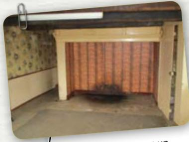
Le sol, revêtu par un carrelage de Beugin, ne présente pas de dalle. Des remontées d'humidité et des déformations du sol sont constatées.
