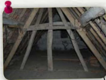
Quatre fermes composent la charpente en bois, ayant fait l'objet de quelques renforts lors de la rénovation de la couverture, intervenue dans les années 1970. Les combles présentent peu d'accès. Seul un escalier permet de monter à la mezzanine, dans l'extension.
